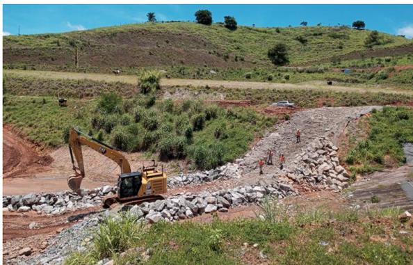
Figura 7 – Concretagem canal à jusante do contrapilamento OE
