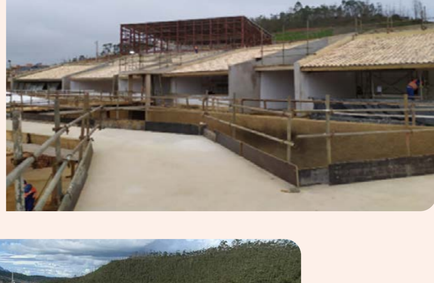
Instalação dos telhados das salas de aula.
