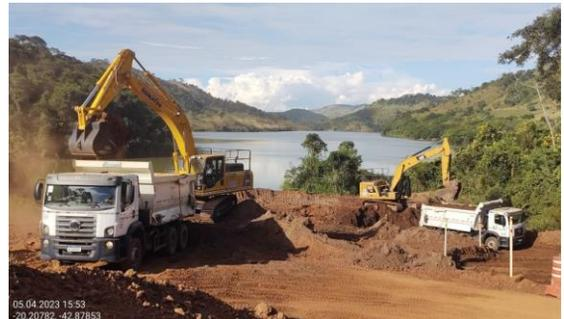
*Figura 2 – Remoção de sedimentos setor 5 para bacia 2*
