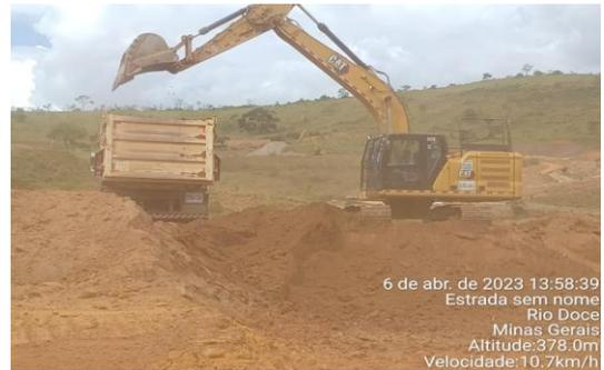
*Figura 1 – Remoção de sedimentos da estrutura ADP8 / AAS1 para área de contrapilamento*
