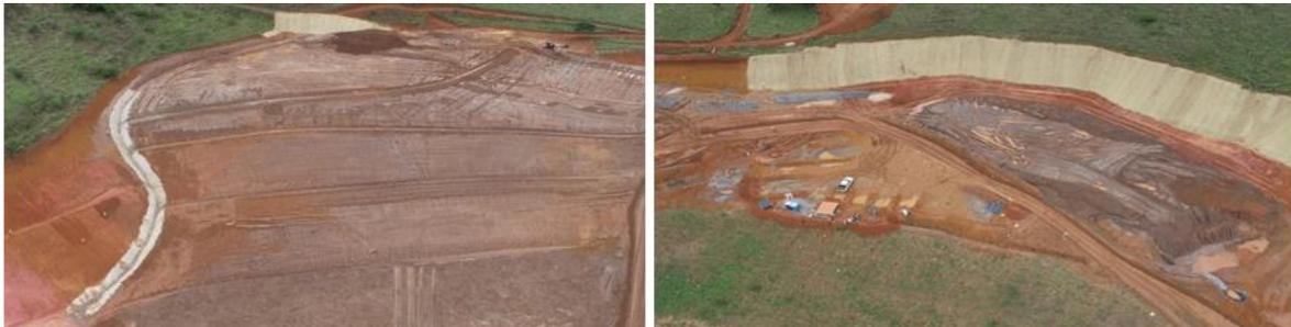
*Figura 14 – CP 01 Argamassado e Bioengenharia (Pilha 01)*
