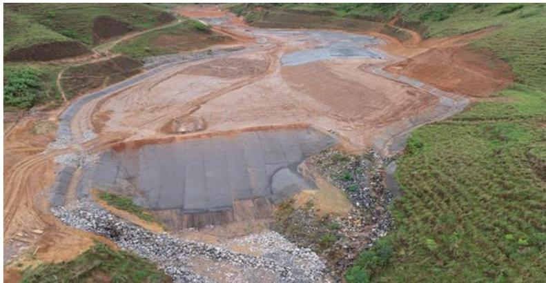
*Figura 13 – Proteção com Geobag (área de contrapilamento à montante Dique Principal)*
