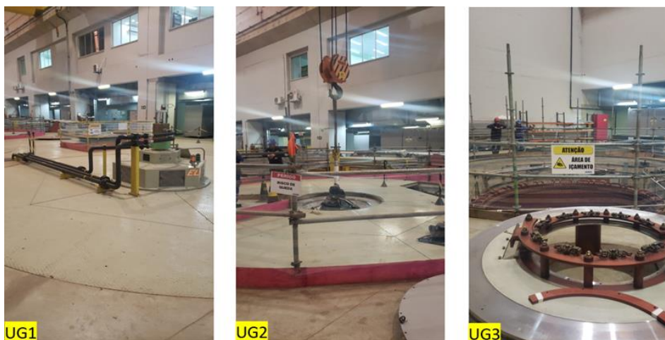
Figura 17 – Atividades na casa de força
