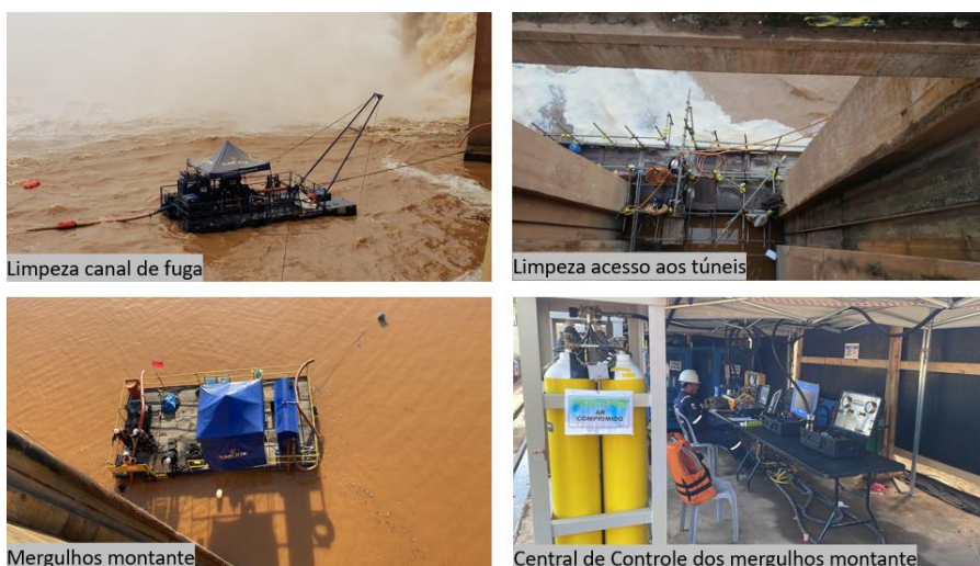
Figura 16 – Fotos da limpeza jusante e montante
