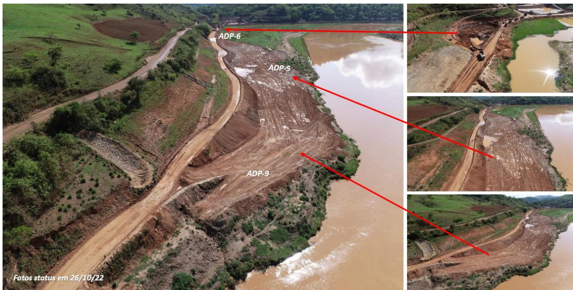
Figura 4 - Foto aérea das áreas de desaguamento primário do reservatório da UHE
