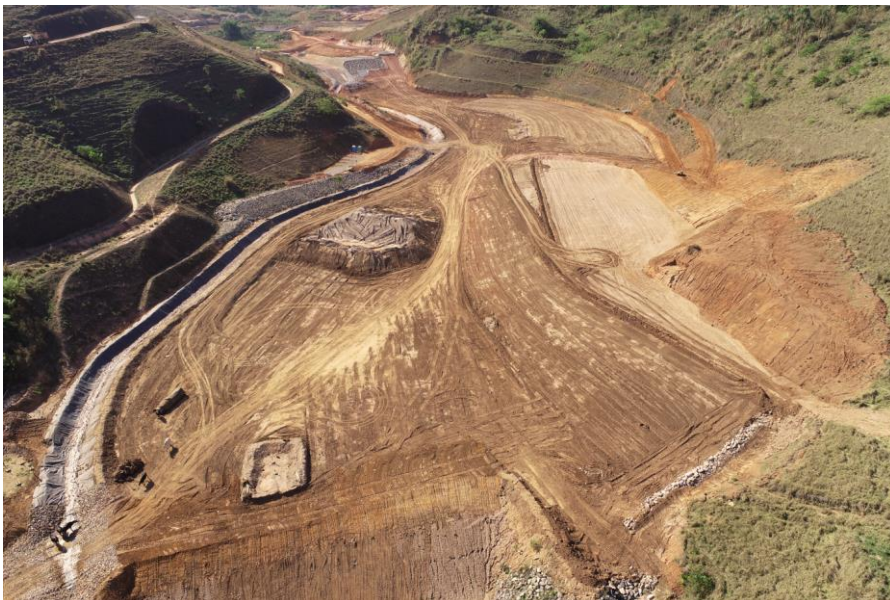
Figura 6 - Compactação de sedimentos O.E Dique Principal
