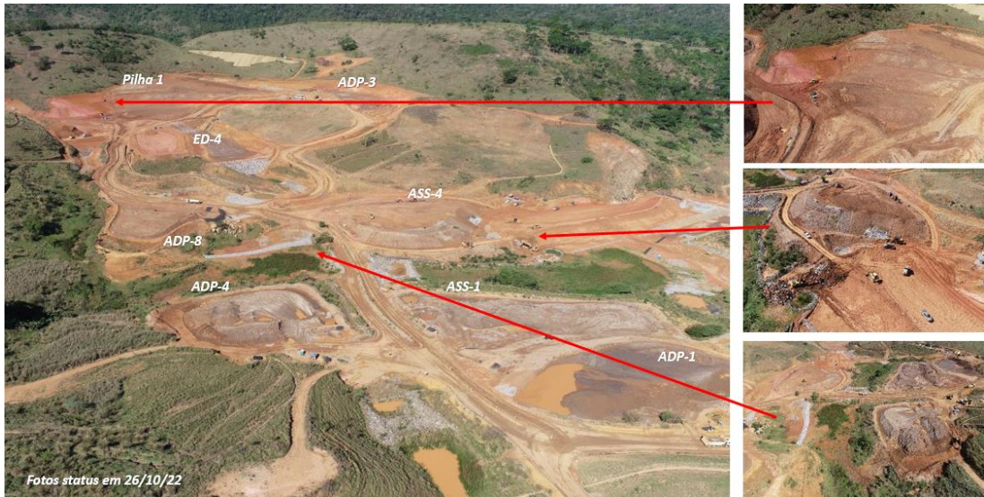
Figura 3 - Foto aérea das áreas de desaguamento primário e secundário do Setor 11
